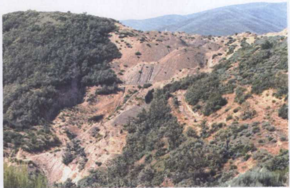
FOTO nº 7.4. - FENOMENOS DE EROSION SUPERFICIAL E INTERNA. INESTABILIDAD DE LA ESTRUCTURA
