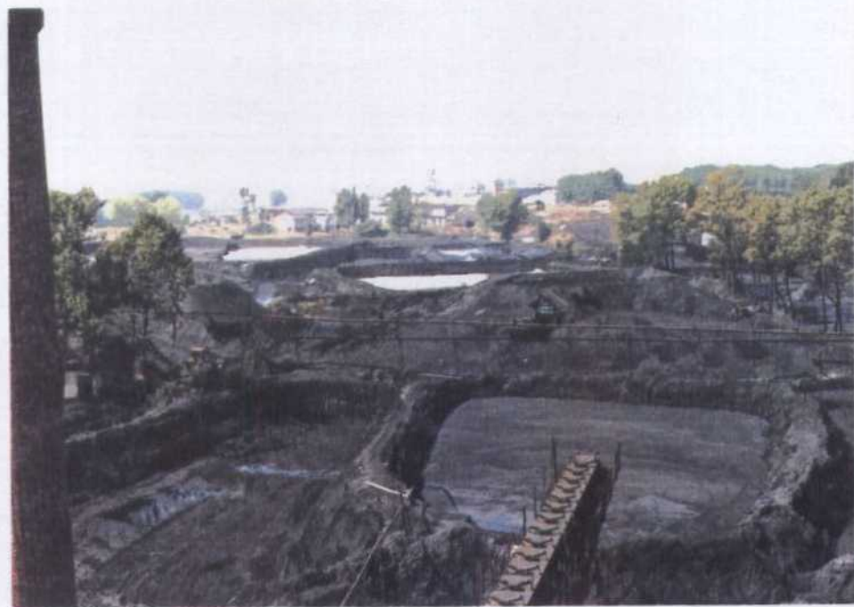
FOTO nº 10.4. - BALSAS TIPO EN LA MINERIA DEL CARBON OBSERVESE SUS DIQUES PERIMETRALES Y EL EMPLAZAMIENTO
