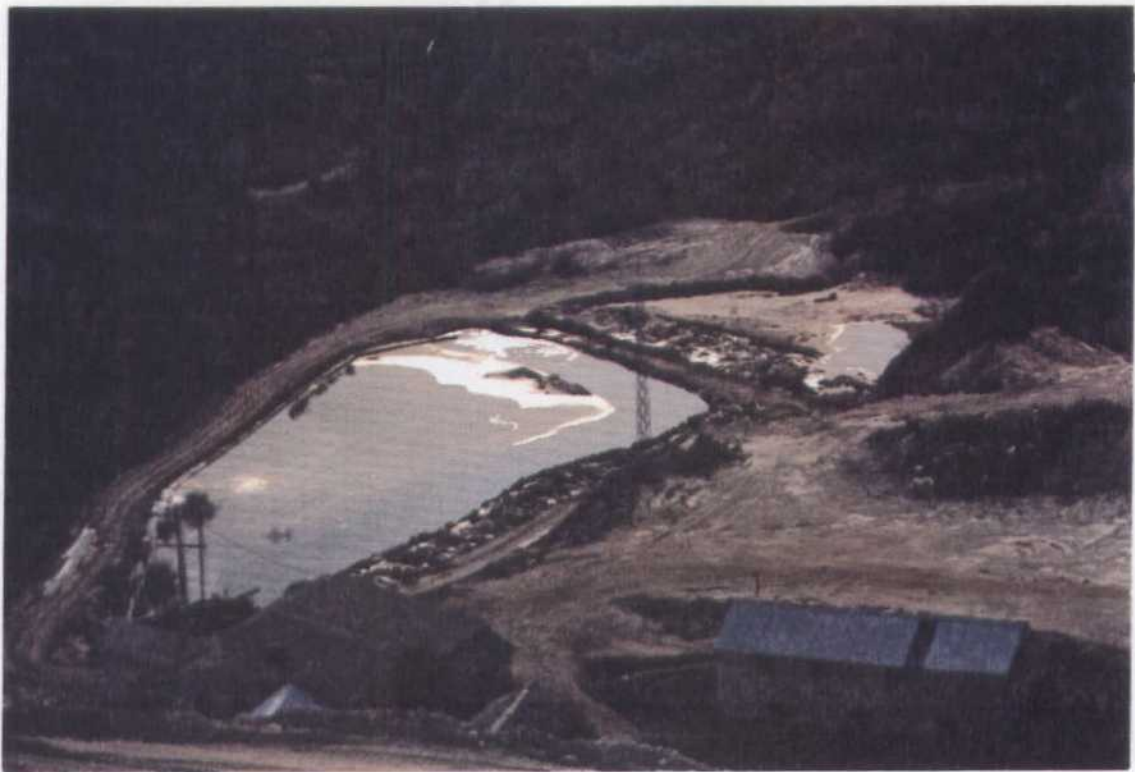
FOTO nº 10.3. - BALSAS DE LAVADO DE MATERIALES DE SILICE OBSERVESE SU EMPLAZAMIENTO EXCAVADO EN LA ROCA
