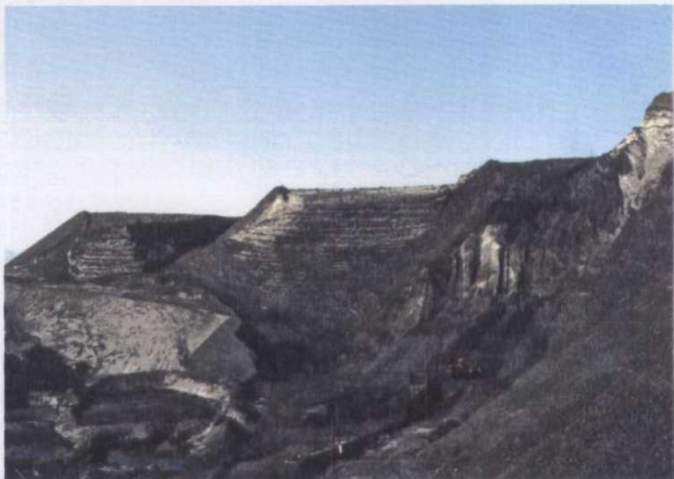
FOTO n º - EFECTOS EROSIVOS Y SOCAVACION MECANICA
