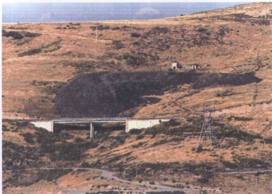
FOTO nº 3.1. - UBICACION EN VAGUADA CON EFECTO PRESA
