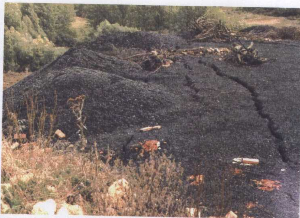
FOTO nº 7.2. - DEFINICION DE GRIETAS, INESTABILIDAD DE LA ESTRUCTURA
