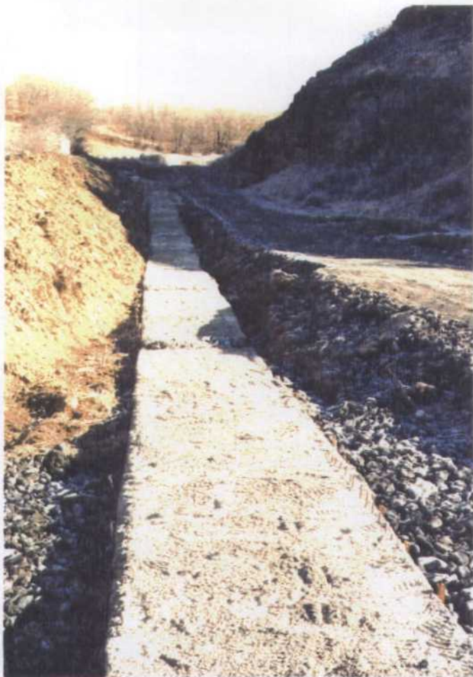
FOTO nº 10.1. RECOGIDA DE AGUAS DE ESCORI TIA MEDIANTE CANALES DE CIN RA DISPUESTOS EN EL PIE DE L ESTRUCTURAS
